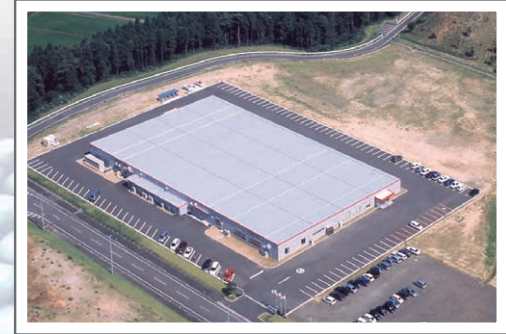
◀白河工場の全景
