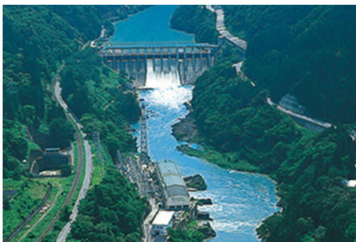
宮下発電所（東北電力）
