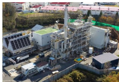
バイオマス発電所（株式会社エフオン白河様より提供）
