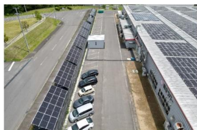
白河工場の空きスペースに太陽光パネルを設置
