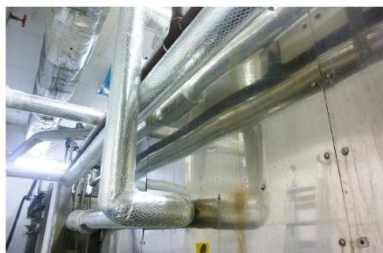
配管を保温し蒸気熱のロスを低減する
